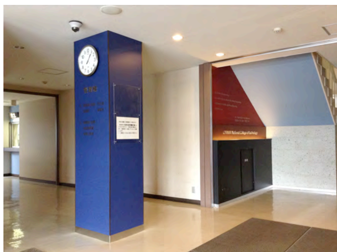
管理棟エントランス改修
