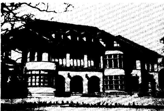
図5 高松宮邸（光輪閣）洋館外観 細川邸と同様にチューダー様式を採用している。 （『高松宮日記』第八巻付録8 1997年）
