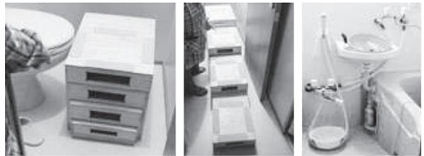
図2 トイレに入れ子式階段状の移乗台を設置し、水栓を増設した例
