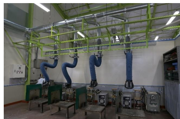
図3 更新後の溶接ヒューム集じん装置
