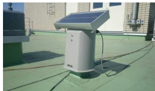
ソーラーJet 脱気塔
