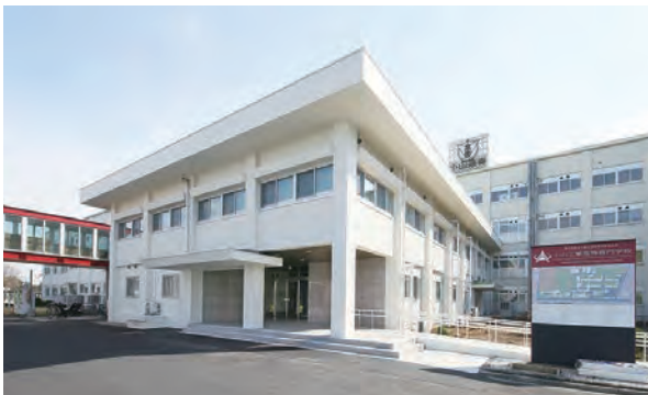
一般管理棟 外壁改修
