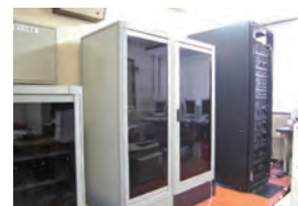
ネットワークサーバ群 Network Servers
