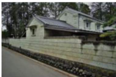
大谷石の建物
